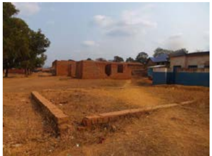
Angefangener Bau eines Schulgebäudes.
